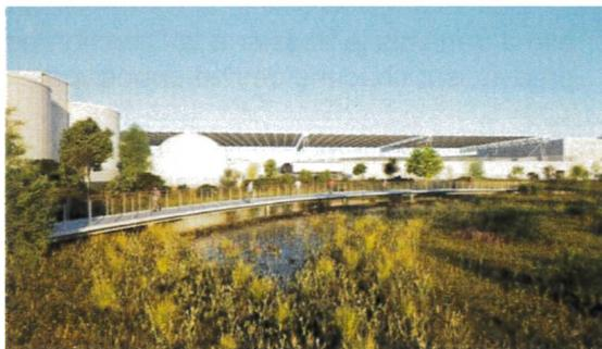
Le projet propose notamment la construction d'une passerelle en béton monolithique, anti-dérapante, équipée d'un garde-corps à câbles inclinés vers l'intérieur et d'une main courante en bois. Cette variante présente une facilité d'entretien par rapport à une passerelle en bois.
